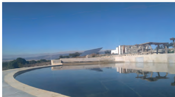
Figure 17. L'énergie solaire utilisée pour le pompage de l'eau et l'électrification rurale à Dar elhenchir, Gîte à Oueslatia, Kairouan
