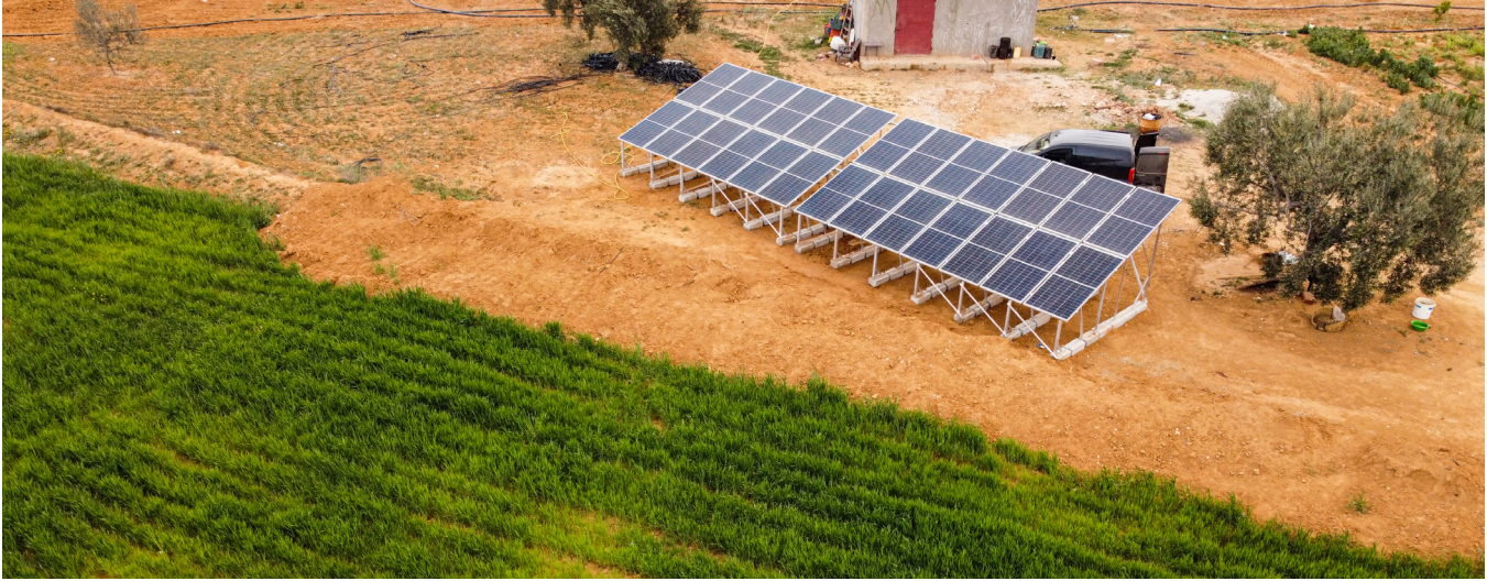
الشكل 4. نظام ضخ المياه بالطاقة الشمسية الكهروضوئية بقدرة 10.4 كيلوواط أقصى لمزرعة السيد عبد الله بن منصور في قرية شربان في تونس
